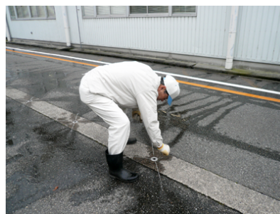
消雪装置のノズル点検
