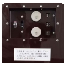
非常用コンセント（ふたを外した状態） AC100V と USB コネクタの同時使用が可能です （最大で使用した場合 100VA まで可能）
