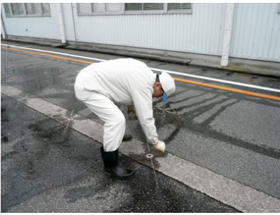
消雪装置のノズル点検
