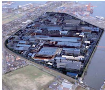
(富山製造所全景)
