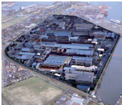
(富山製造所全景)
